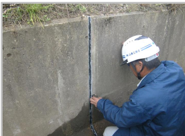
成型ゴム挿入工 (直角部:90° についても一本物施工可)
