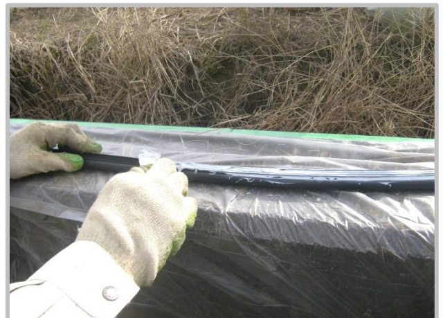
接着剤塗布工 (接着剤塗布状況)
