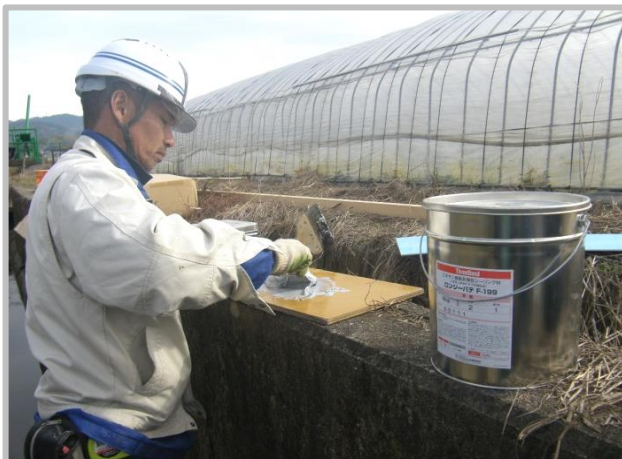
接着剤塗布工 (接着剤混練状況)
