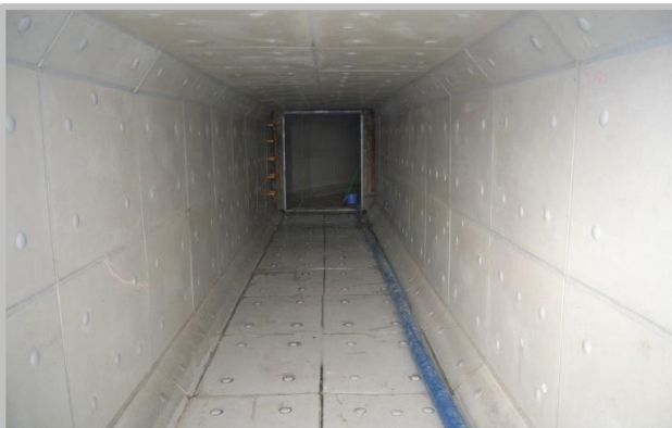
下水処理施設補修
