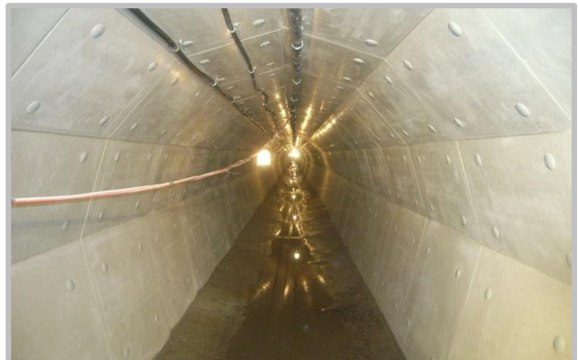
導水路トンネル補強
