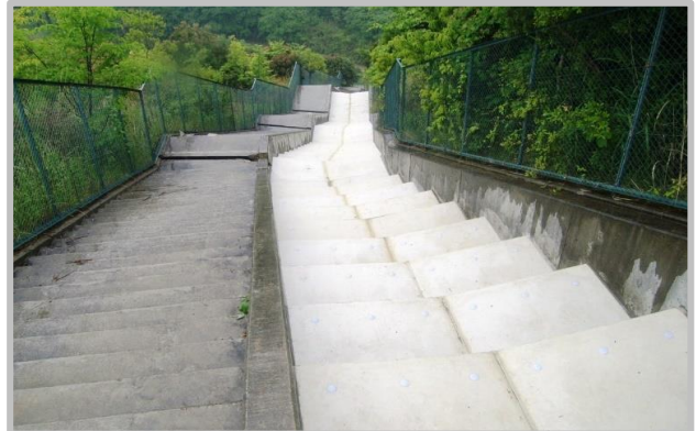
水路落差部補修
