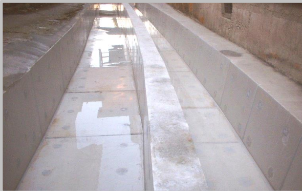
農業水利施設補修
