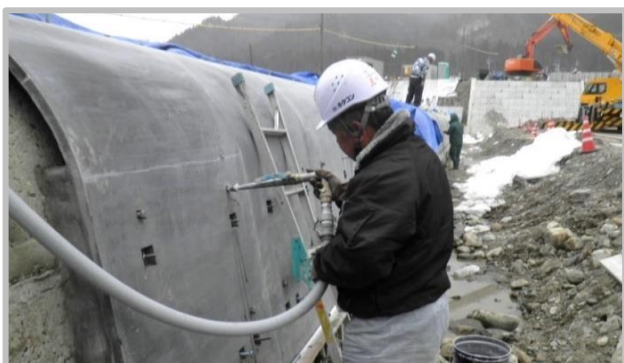
⑤ 無収縮グラウト充填工
