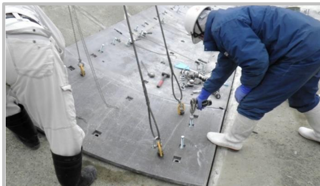
② パネル設置工(高さ調整)
