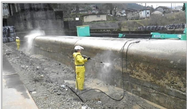
① 下地処理工(高圧洗浄)
