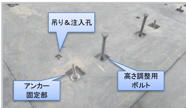
④ パネル設置工(パネル固定)
