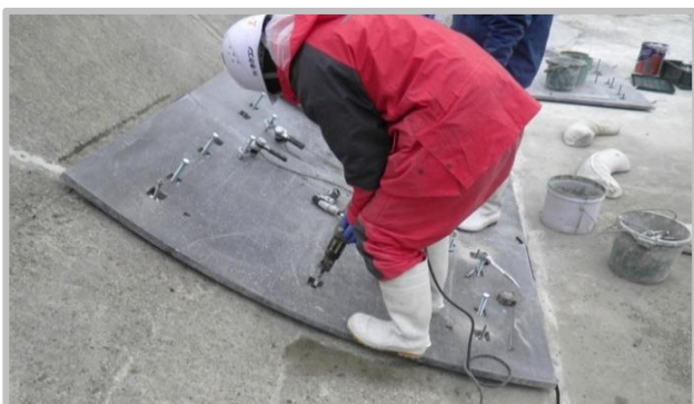
③ アンカー工
