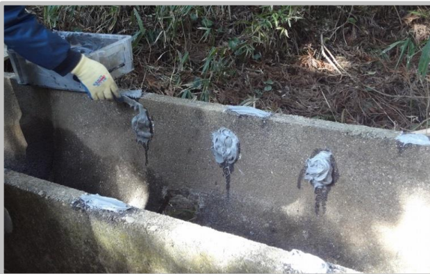
③ プライマー・接着剤塗布工
