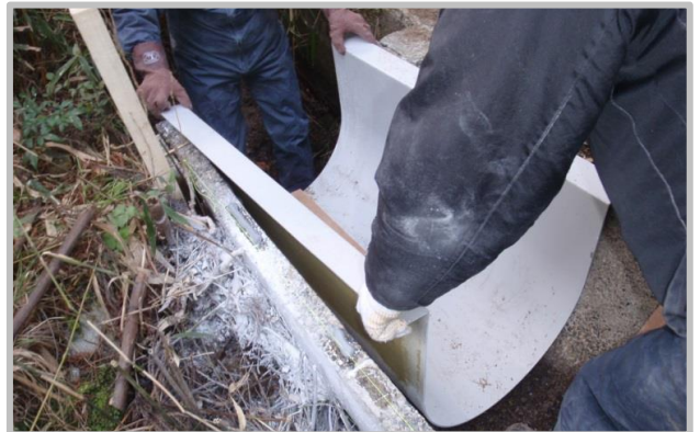
④ FRPリ्यूームカバー設置工
