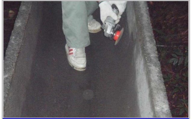
② 下地処理工(ケレン・高圧洗浄)
