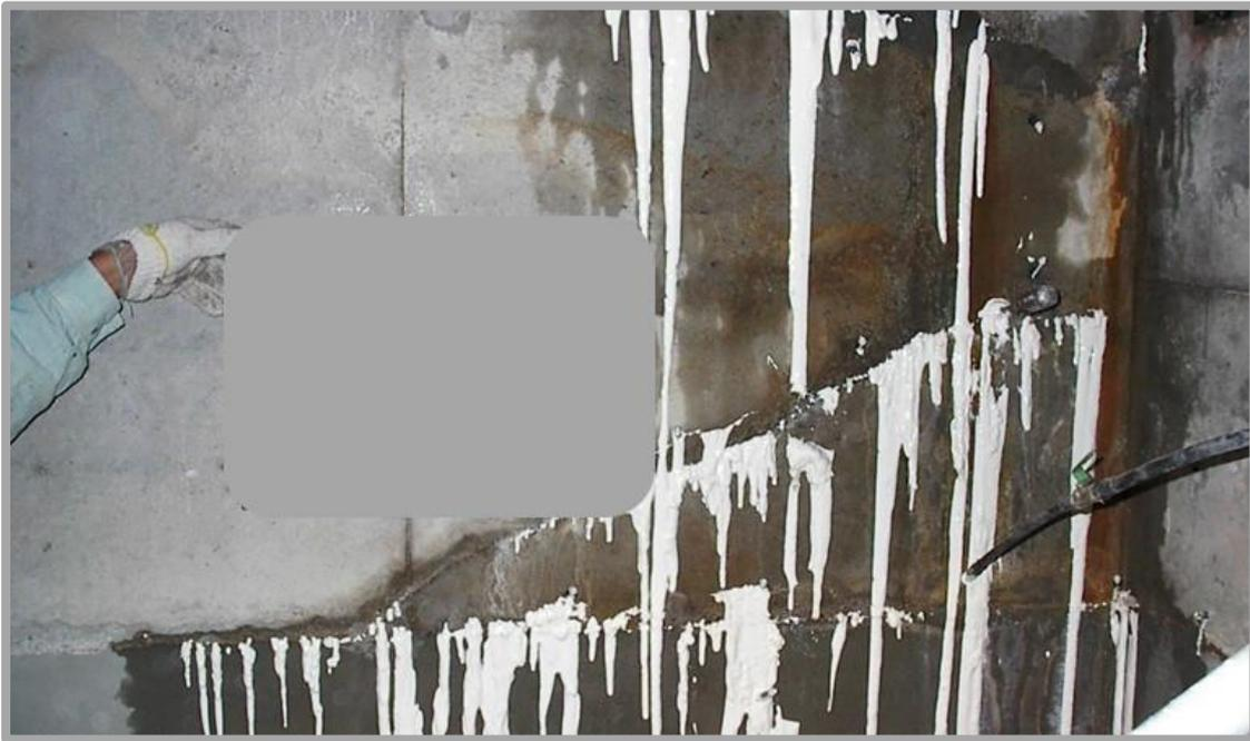
ウォーターカット工法は、コンクリート構造物における漏水原因(ひび割れ・打ち継ぎ・ジャンカ等)に対し、躯体コンクリート背面に『特殊ポリマー樹脂止水材』を高圧注入し、外部の未出水部を含む全ての漏水原因から注入材を逆流浸透させることで、コンクリート裏面(躯体外部)に遮水層を形成し、長期的な止水を目的とした工法です。
