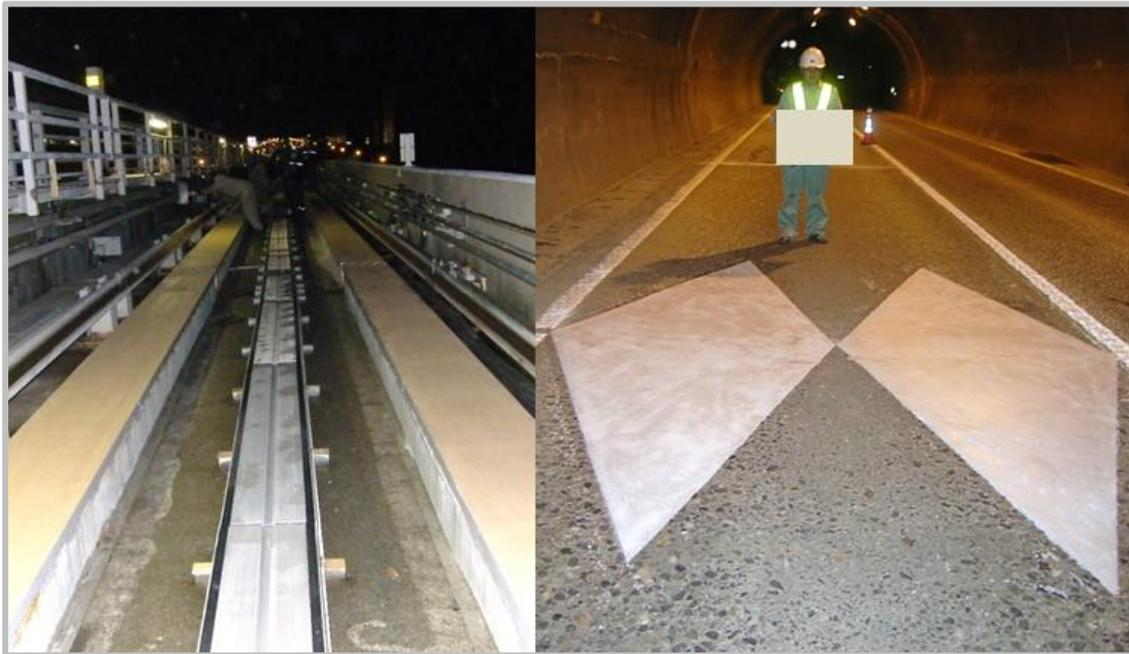
ドーロガード工法は、速乾性耐久補修材『メタクリル樹脂モルタル』(ドーロガード)と、浸透性メタクリル樹脂(パーミタイト)の組み合わせで、土木構造物の補修や補強、耐久性の向上を行う工法です。
