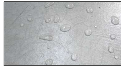
【 施工後 撥水状況 】
